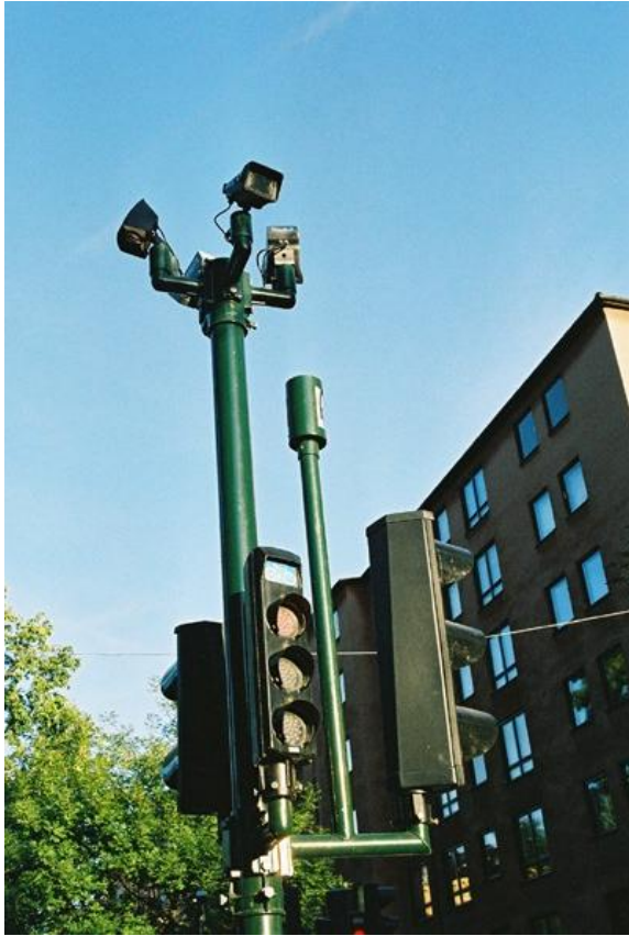
Foto: Fyra sensorer monterade på en stolpe för förlängning respektive automatisk detektering av gående och cyklister i provkorsningen. Nedan ritning över samma korsning.
