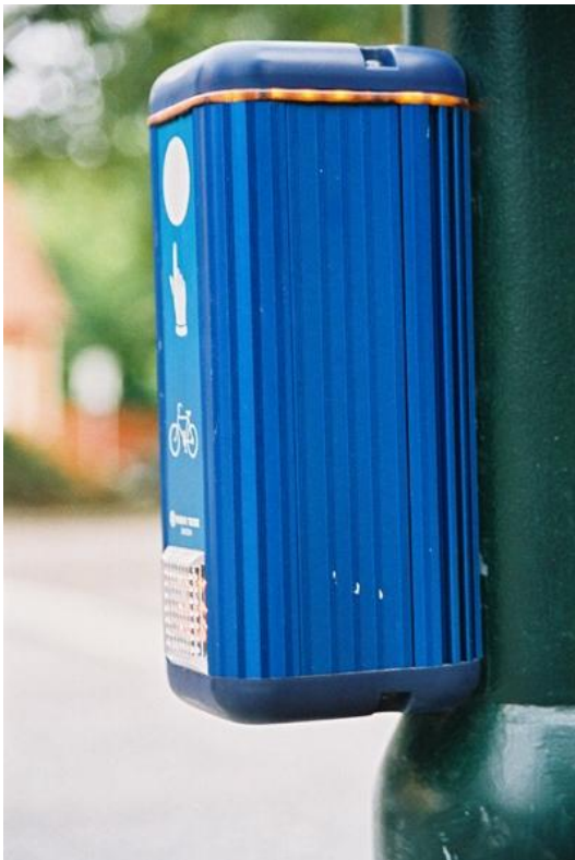
Foto: Tryckknappslåda med indikeringslampa (ljusdiodsringen upptill) synlig runt om.
