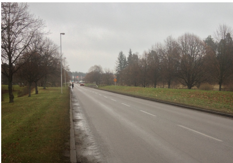
Figur 2 Provplats nr 4 enligt tabell 1. Söderleden i Linköping.
