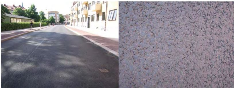
Östgötagatan (norra), Linköping, lokalgata, ny beläggning ( Q_d = 0,044 \text{ cd/m}^2/\text{lx} )
