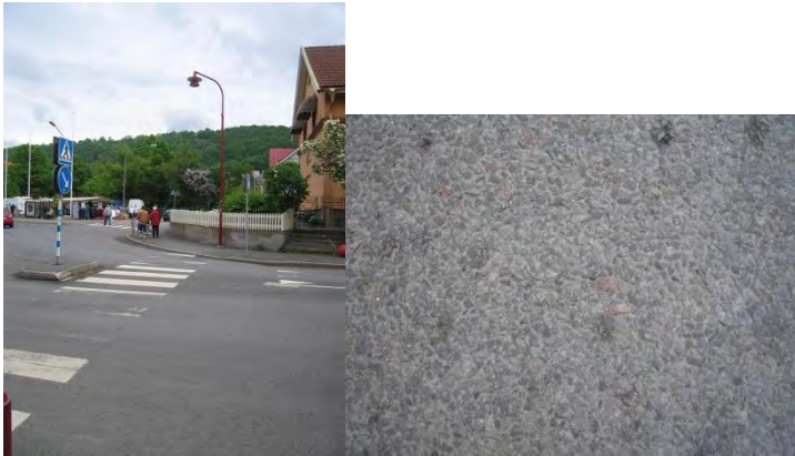
Drottninggatan, Huskvarna, lokalgata ( Q_d = 0,058 \text{ cd/m}^2/\text{lx} )
