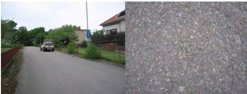
Ekängsgatan, Motala, lokalgata ( Q_d = 0,070 \text{ cd/m}^2/\text{lx} )
