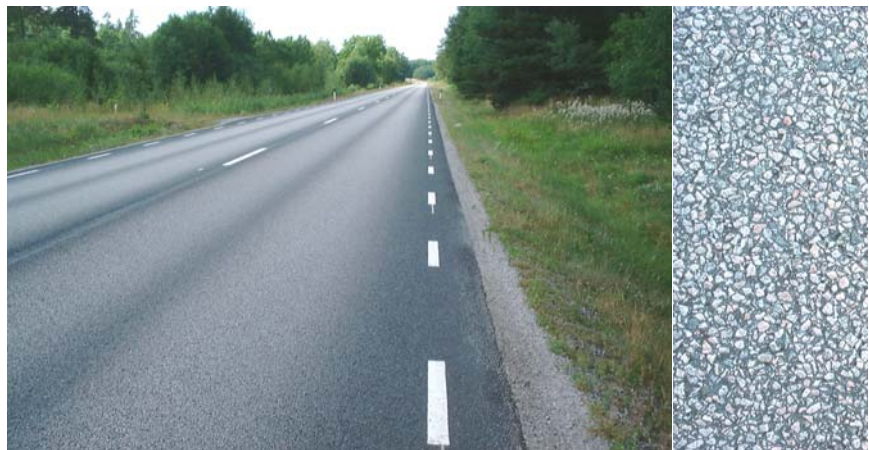
FIGUR 3-2 ABS – stenrik asfaltbetong med relativt ljus stenmaterial. Stenarnas ljushet är viktig för ljusreflexionen eftersom de förekommer rikligt på ytan.
