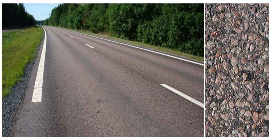
FIGUR 3-4 TSK – tunnskiktsbeläggning. Stenarnas ljushet är viktig för ljusreflexionen eftersom de förekommer rikligt på ytan – i detta fall porfyr.
