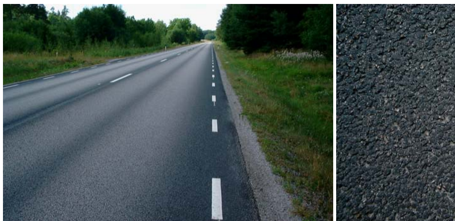
FIGUR 3-3 ABS – stenrik asphaltbetong med relativt mörkt stenmaterial. Stenarnas ljushet är viktig för ljusreflexionen eftersom de förekommer rikligt på ytan.
