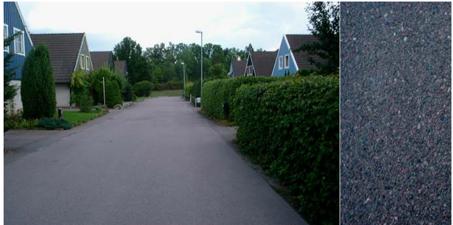
FIGUR 3-1 ABT – tät asfaltbetong. Stenmaterialets ljushet är av mindre vikt eftersom stenar på ytan endast förekommer i mindre omfattning.
